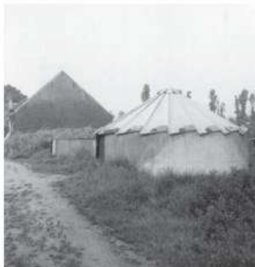
De twee in 1935 gebouwde silo's met daarachter de mestvaalt en de 'oude' schuur. Op de voorste silo ligt een dak tegen de regen (1965)
