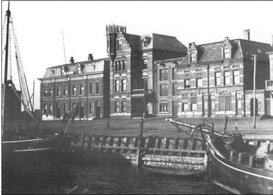
Op het Schanshoofd. Links het gebouw van het Loodswezen en rechts daarvan het kantoor van L. Smit & Co met daarop de 'uitkijk' waar de 'luchtwacht' z'n uitkijkpost had. Nu zijn beide gebouwen in gebruik.
