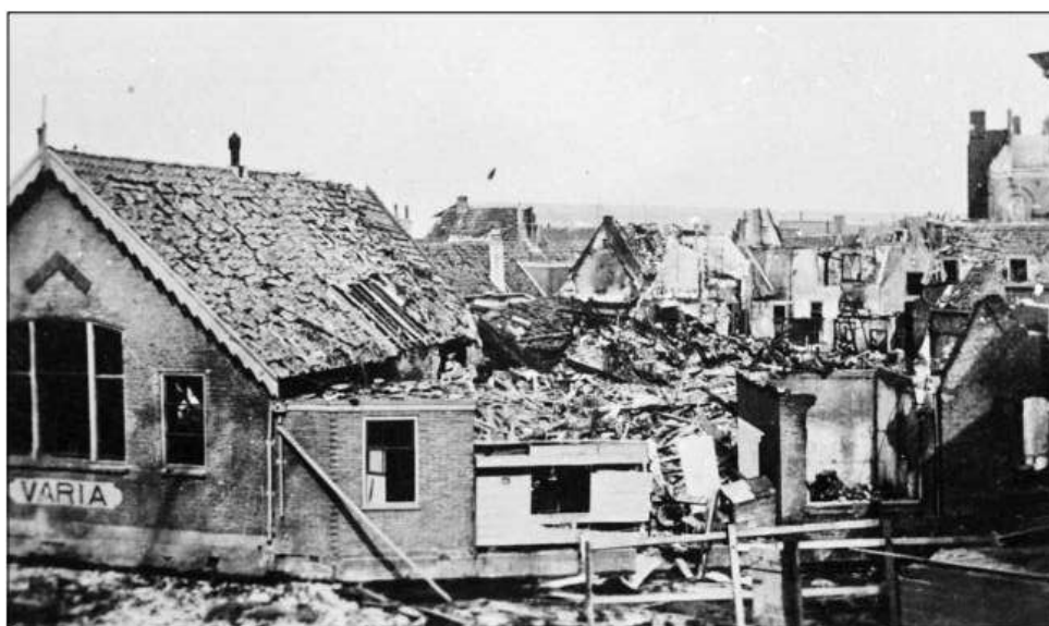
De plaats van de ramp vanuit een ander standpunt. Gebouw 'Varia' is zwaar beschadigd, maar iets verder blijkt alleen totale verwoesting.
