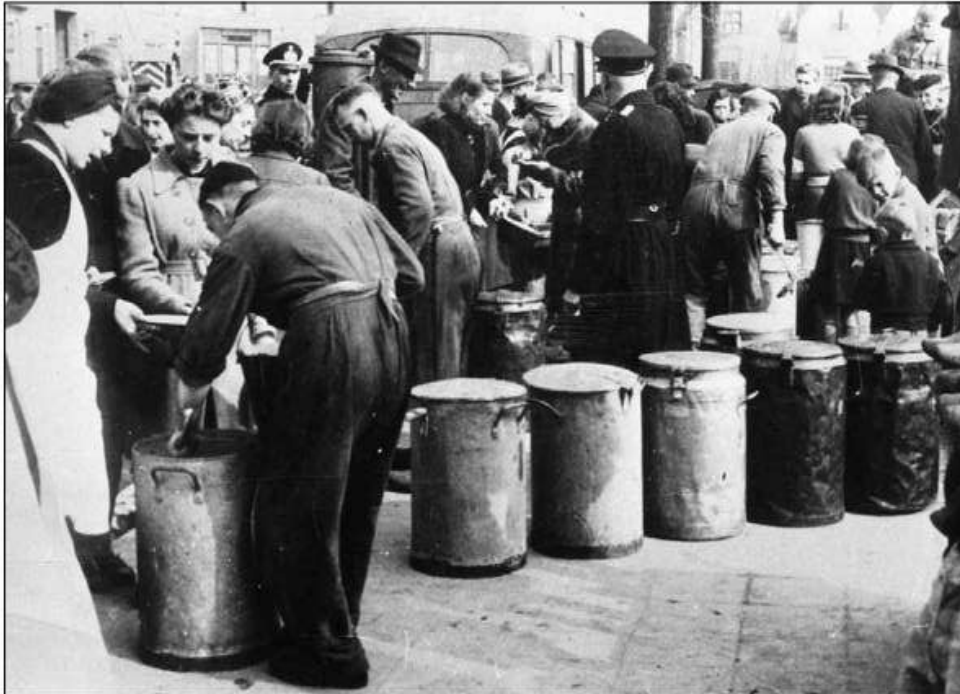
Na het bombardement (geen stroom, geen gas), gaarkeuken in de open lucht.
