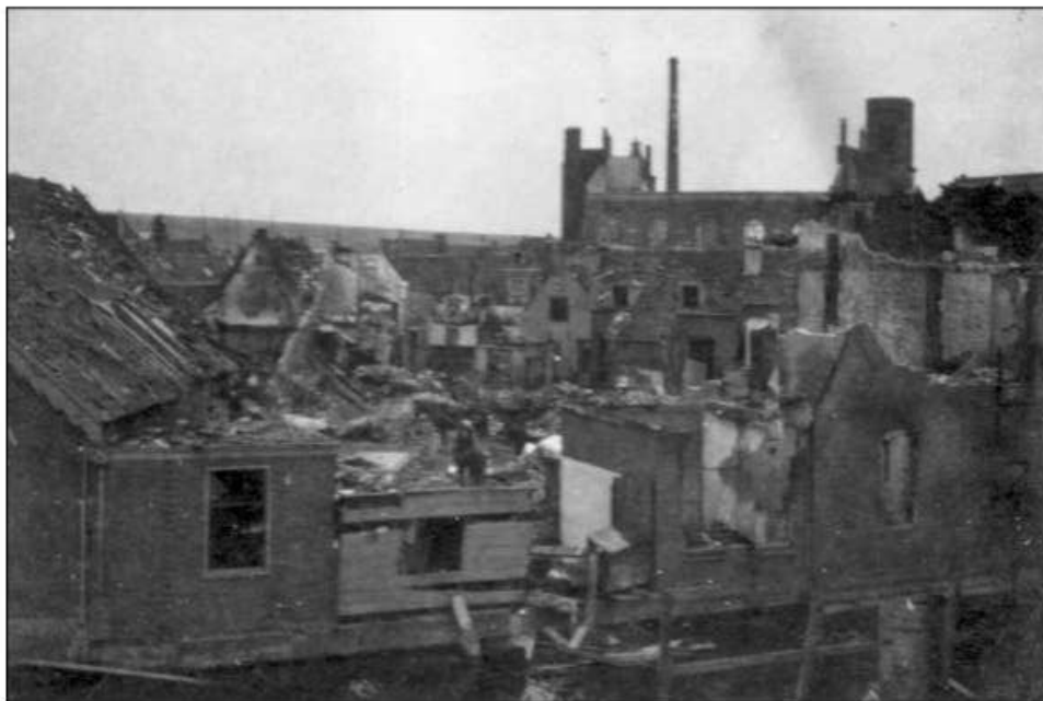
Na het blussen van de brand resteert een verwoest stadsdeel.
