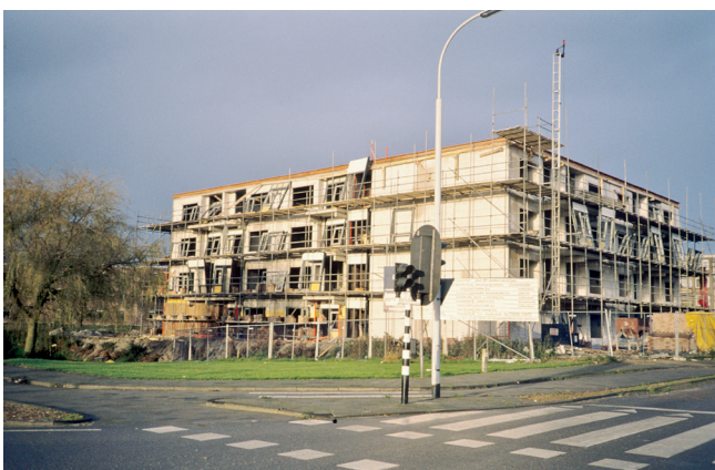
Zonneburcht in aanbouw.
