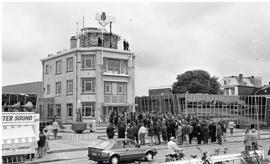
Opening van de linkervleugel van het gebouw in 1992.
