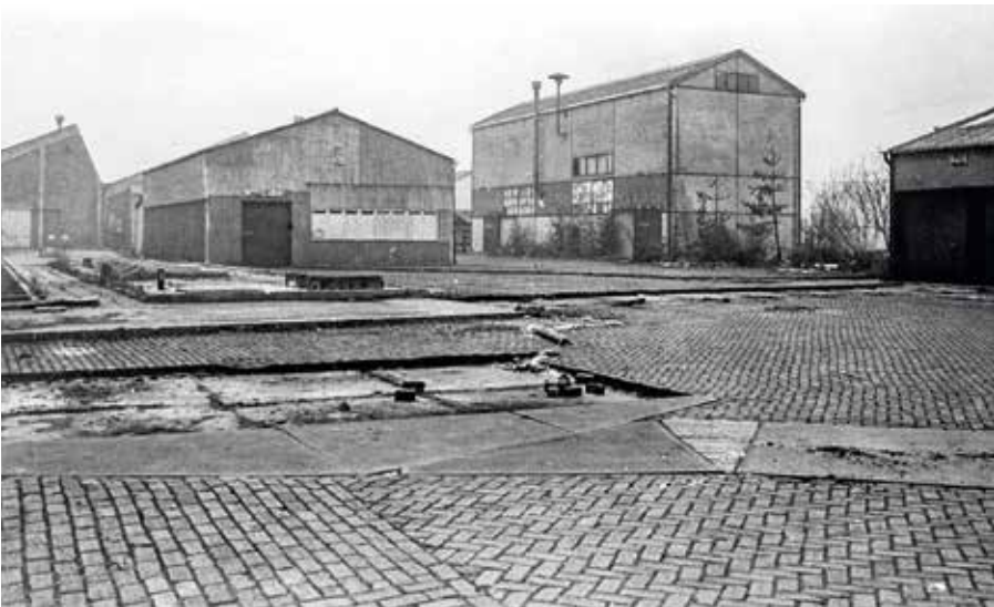
Terrein van de Vereenigde Touwfabriek tijdens de sloop. Op het hoge gebouw rechts zien we nog de BB-sirene op het dak. De foto dateert uit 1982 en is ongeveer genomen vanaf de Nieuwe Schoolstraat.
