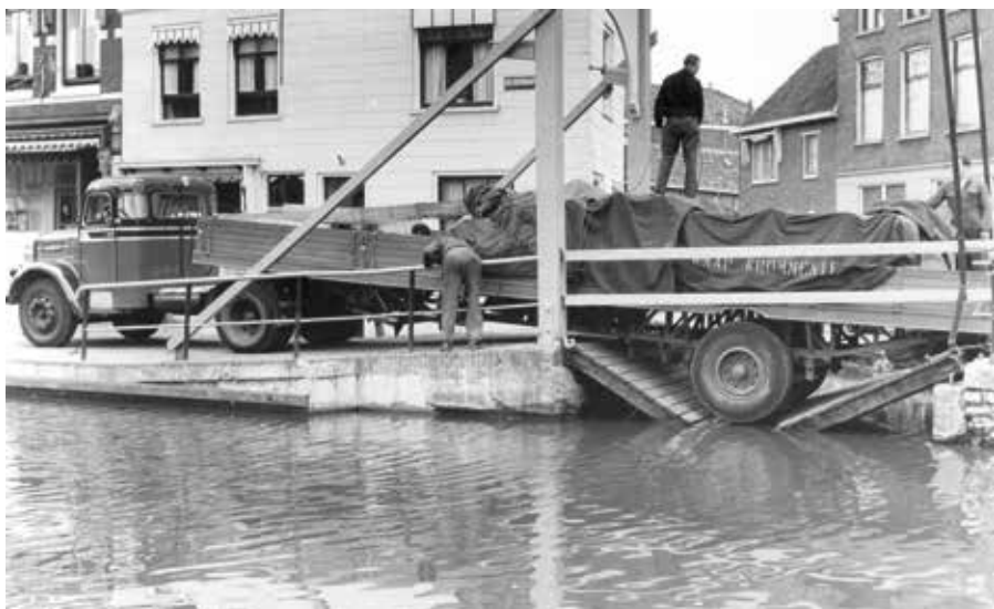
Een trekker met oplegger geladen met rollen linoleum uit Krommenie, die vanaf de Noordvliet de Fortegrachtbrug is opgedreden, is door het brugdek gezakt. De bestuurder was op zoek naar de Vereenigde Touwfabriek. De foto dateert van 7 of 8 augustus 1961.
