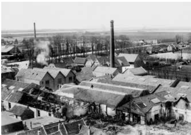
Gedeeltelijk door brand vernielde gebouwen van de Touwfabriek in 1929.
