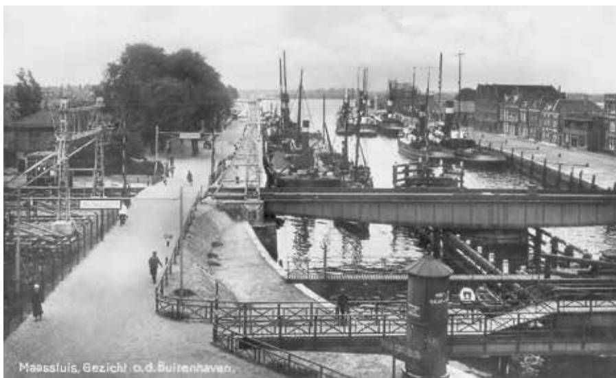
De aanleg van de spoorbrug betekende minder ligplaatsen in de haven.
