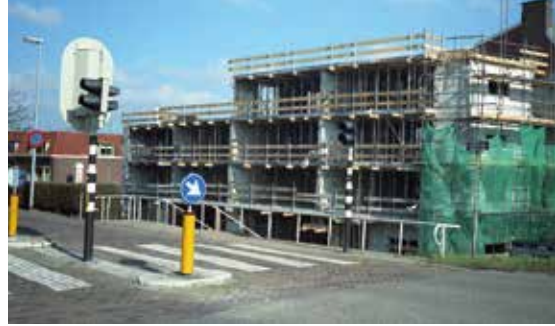
1999, nieuwbouw appartementen naast Luxor in volle gang.
