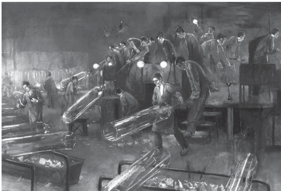
De cylinders die de glasblazers maken worden later opengesneden en uitgerold tot vensters. (Heijenbrock, coll. Nederlands Openluchtmuseum)
