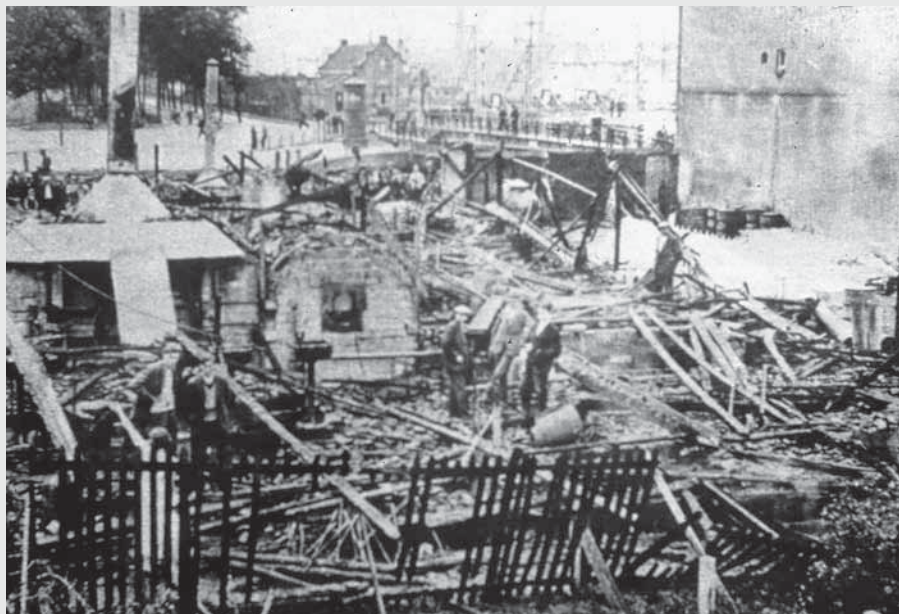
De tweede glasfabriek na de brand. Op de achtergrond het Havenplein en de Kippenbrug.
