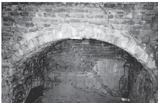
Steunbogen in de dijk onder de Kleine Kerk kwamen tevoorschijn bij de afbraak in 1966.
