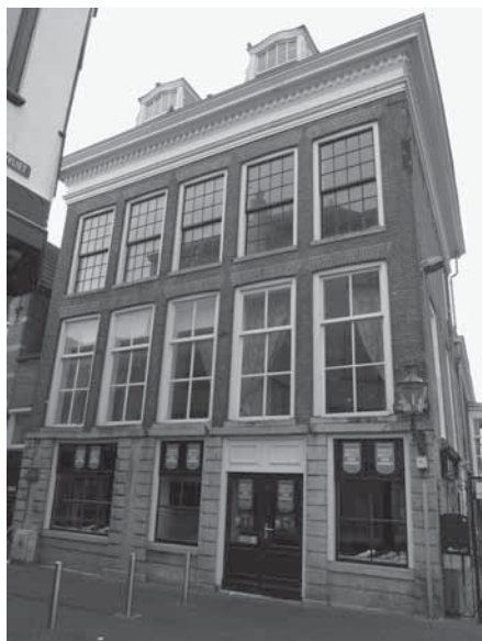
Voorgevel met classicistische indeling: natuurstenen basement, meerruitsvensters op de 1e verdieping en dakkapellen met spiegelbogen.
