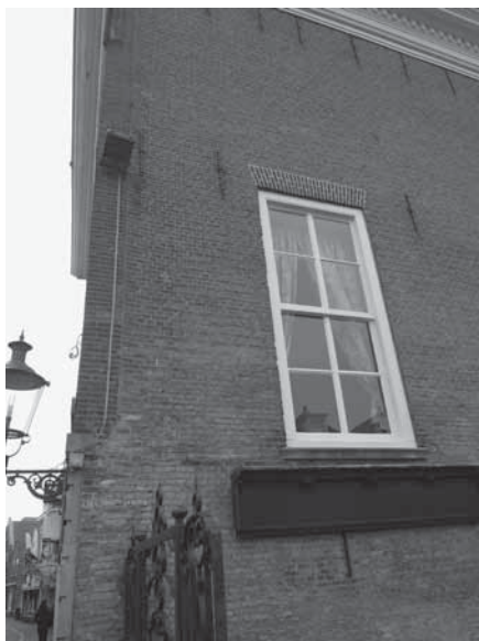
Bouwsporen op de aansluiting van de voor- en zijgevel.
