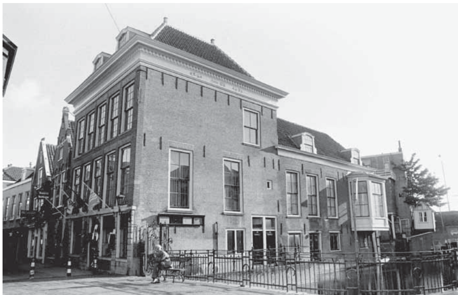
Door de steile dakschilden rondom lijkt het huis nog groter. Op de daklijst staat o.a. 1731.
