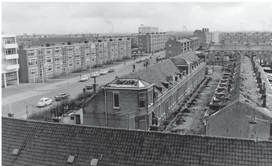
Sloop van de Emmastraat in 1969, de eerste fase van de sloop van de oude binnenstad. Op de voorgrond huizen aan de Lijnstraat, links de P.C. Hooftlaan. De foto is genomen vanaf het dienstencentrum De Vliet.
