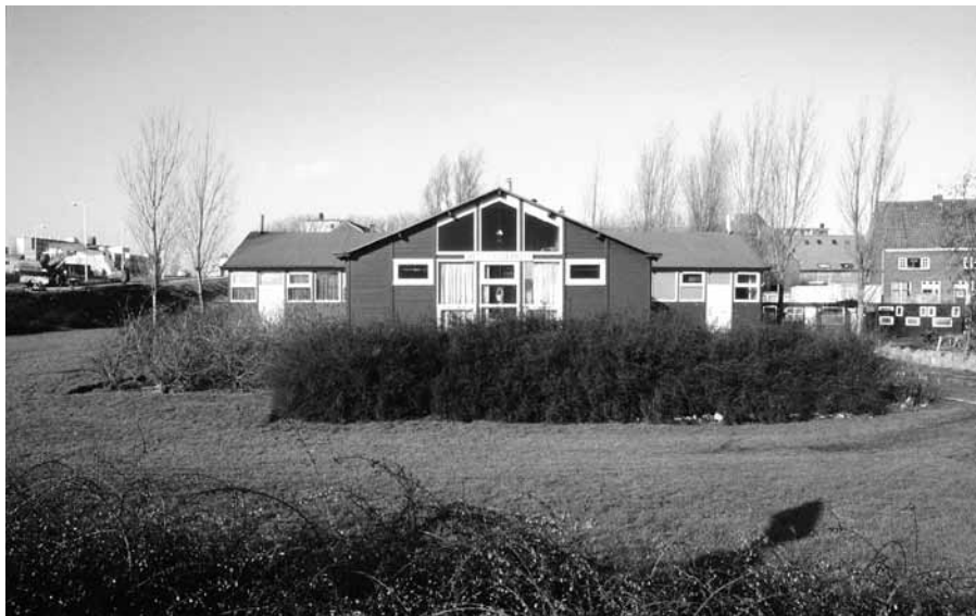
De voormalige houten noodkerk Ichthus deed dienst als Het Poldergebouw aan de Rozenlaan en bood onderdak aan de bibliotheek.
